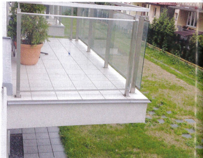
Fot. 2. Zastosowanie aluminiowych profili okapowych na tarasie
