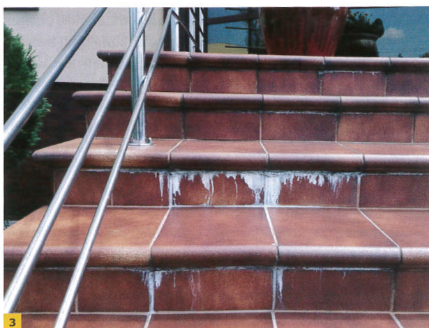
FOT. 1–4. Przykłady uszkodzeń: wyciśnięty przez spoinę polimer stanowiący składnik zaprawy klejowej (1), wilgotna, złuszczone zaprawa widoczna po zdemontowaniu płytki posadzkowej (2), biały nalot na okładzinie ceramicznej schodów zewnętrznych (3), zniszczona okładzina ceramiczna ścianki oporowej (4); fot.: Renoplast
