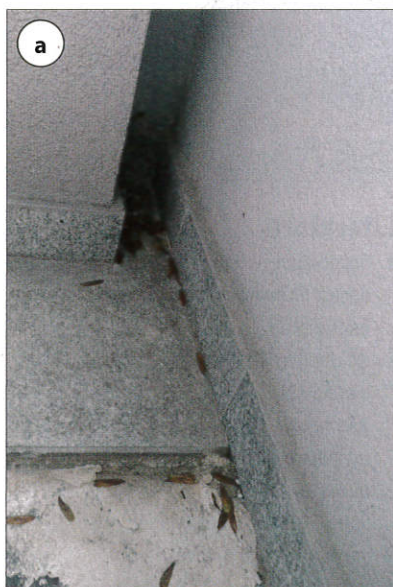
Fot. 1 | a) Balkon z obustronnie ocieplaną płytą oraz balustradą pełną również ocieplaną obustronnie. Zakamarki te może wyglądać ciekawie, natomiast dla takiego układu są praktycznie nie do uszczelnienia; b) pokazane umiejscowienie prowadnicy rolety i sposób jej mocowania może wręcz uniemożliwić poprawną hydroizolację połaci. Dodatkowo widoczne bezmyślne wykonanie przejścia bezbarierowego (fot. autor)
