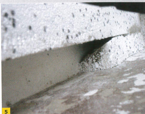
FOT. 5. Wskutek styku jastrychu z częścią nośną ściany powstaje liniowy mostek cieplny; fot.: archiwum autora
