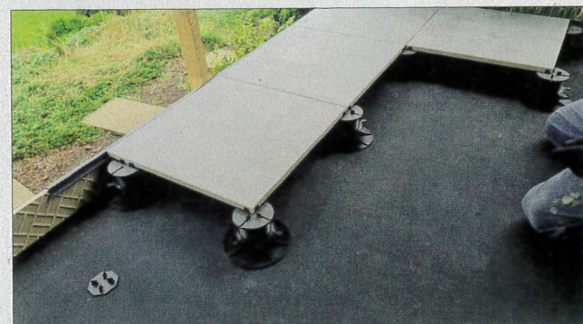
Fot. 6. Układanie płyt posadzki. Profile okapowe zapewniają stabilność płyt w strefie okapowej i estetyczny wygląd
