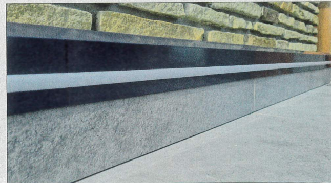
Fot. 7. Zamontowane profile cokołowe Renoplast C1 oraz C2. Możliwy jest montaż listwy oświetleniowej LED
