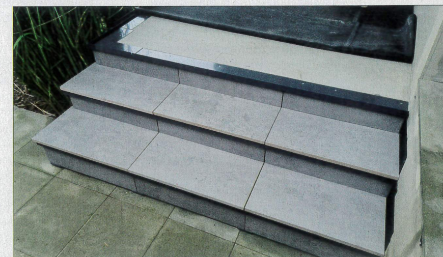
Fot. 8. Montaż płyt i powłoki wodochronnej na schodach należy zacząć od najniższego stopnia
