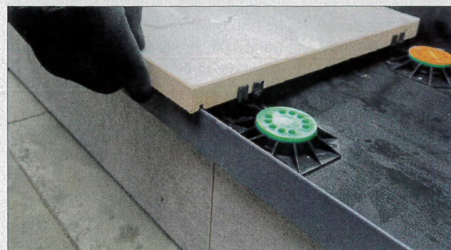
Fot. 9–11. Podstawka dystansowa Smart, profil schodowy Renoplast SW i płyta stopnicy
