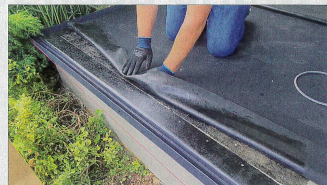
Fot. 4. Klejenie powłoki wodoszczelnej z membrany EPDM
