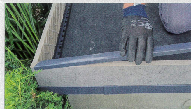
Fot. 4. Klejenie powłoki wodoszczelnej z membrany EPDM
